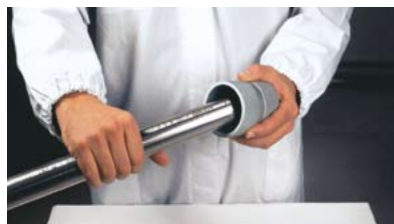
Fig. 16 - Afgratning af rør
