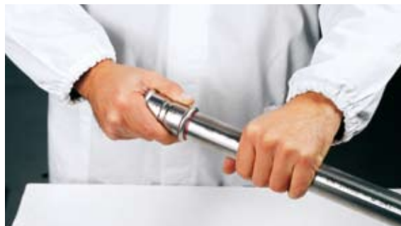
Fig. 21 - Rør indføres i presfittingen
