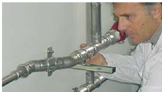
Fig. 23 - Kontrol af pressamling
