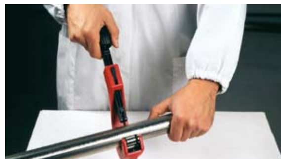
Fig. 15 - Tilskæring af rør
