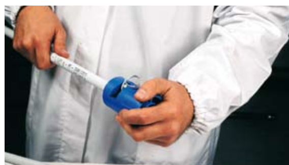
Fig. 19 - Afstripping (AO-SteelPres)
